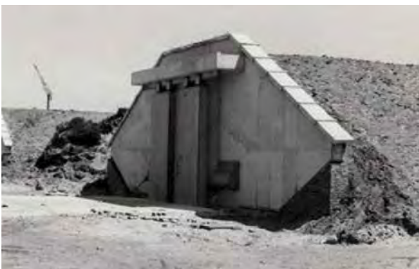
Bunker van het Duitse munitiedepot in Arendonk vlak na de bouw omstreeks 1961.
